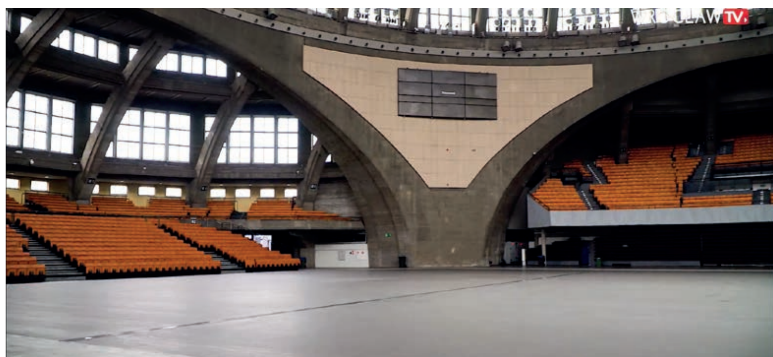
Pod szarą płytą główną znajdują się już nowe pomieszczenia, gdzie będą organizowane wystawy, bankiety i konferencje
